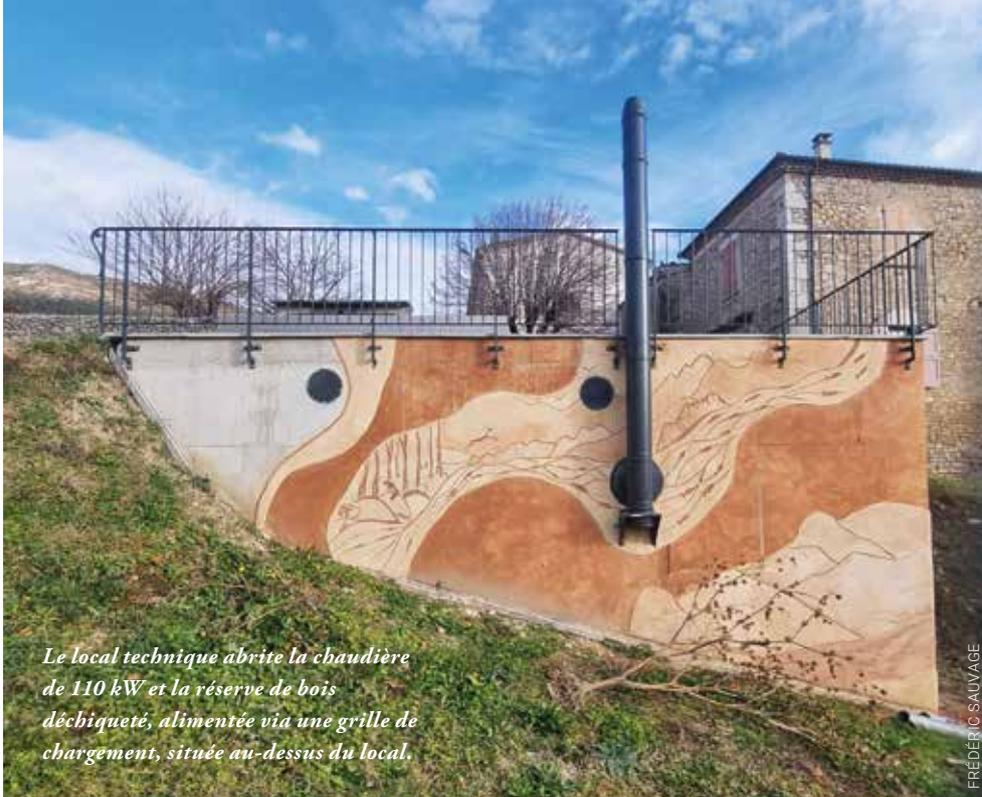
Le local technique abrite la chaudière de 110 kW et la réserve de bois déchiqueté, alimentée via une grille de chargement, située au-dessus du local.
